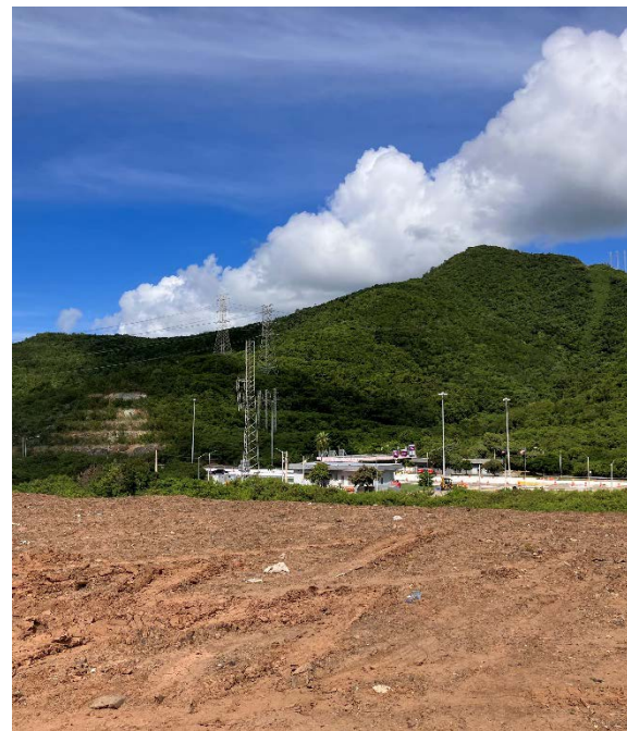
Vertedero de Guayama (Foto de Maya Fein-Cole, NREL, octubre de 2023)
