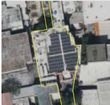
Sistema fotovoltaico en techo existente observado en el Teatro/Centro Comercial Fox Delicias (Brownfields), Ponce.
