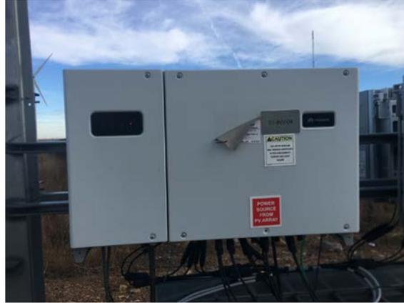
Figure 11. A 50-kVA string inverter (SUN2000-45KTL-US-HV)
