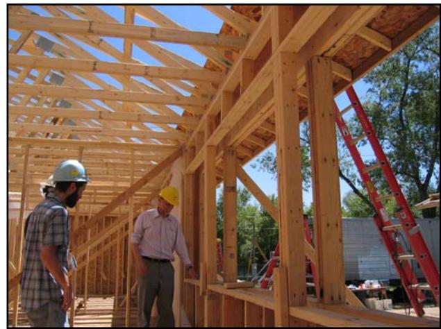
Fig. 3: Double stud wall framing
