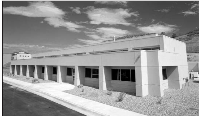
Warren Gretz, NREL/PIX04116
