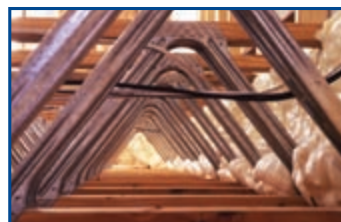
IBACOS, NREL / PIX12937
