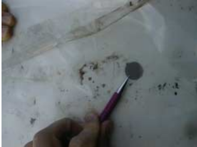
Figure 22. Vestas V44 blade protection receptor/terminal
